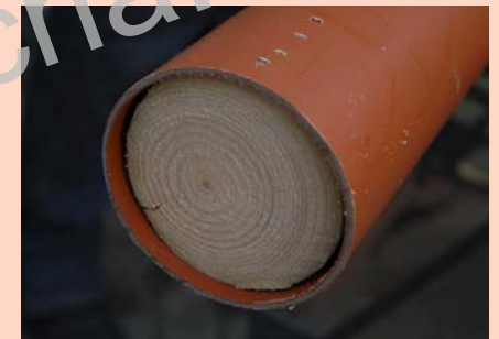
Abb 5: Palisaden im Rohr befestigen
