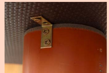
Abb 7: Mit Winkeln stabilisieren.
